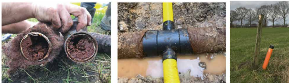
Afbeelding 7: Verstopping met ijzer (links), geïnstalleerde kruisstukken (midden) en een doorspuitstuk (rechts) voor de veldproef in America. Ontleend aan De Wit e.a. (2023a).
